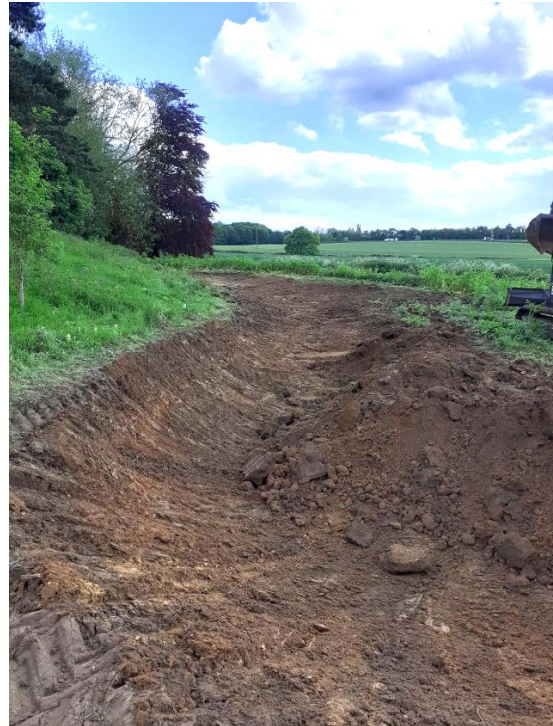
Travaux terminés à Premier Foods
