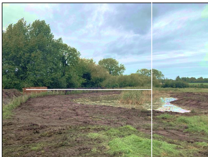
Restauration d'un étang à Ham Fen
