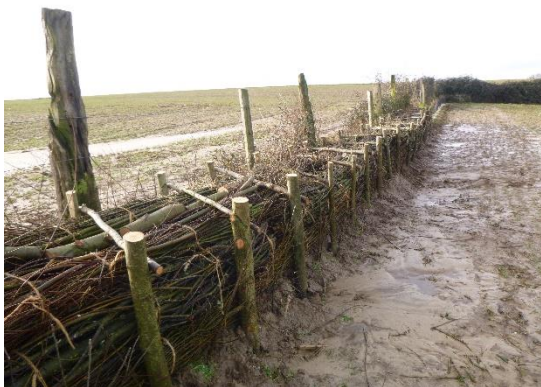
Barrières contre l'écoulement de surface nouvellement créées (fascine)
